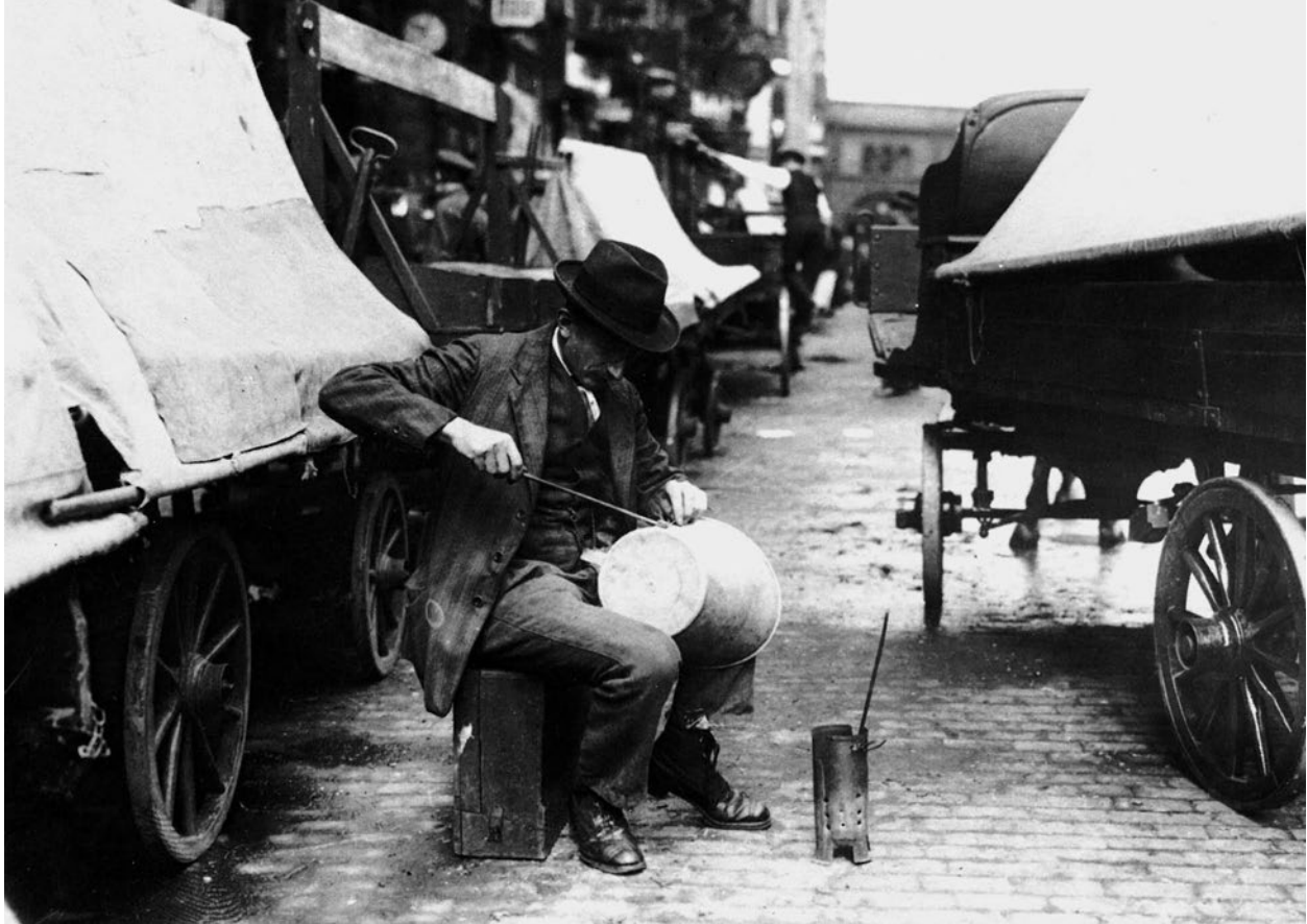
7 Reparaturklempner auf einem Berliner Markt, der einen löchrigen Wassereimer mithilfe der Löttechnik reparierte. Er lötete das Blech mit einer Legierung aus Zinn und Blei weich, um das Loch zu schließen.
