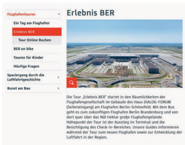
5 Vorabnutzung des noch nicht fertiggestellten Flughafens
