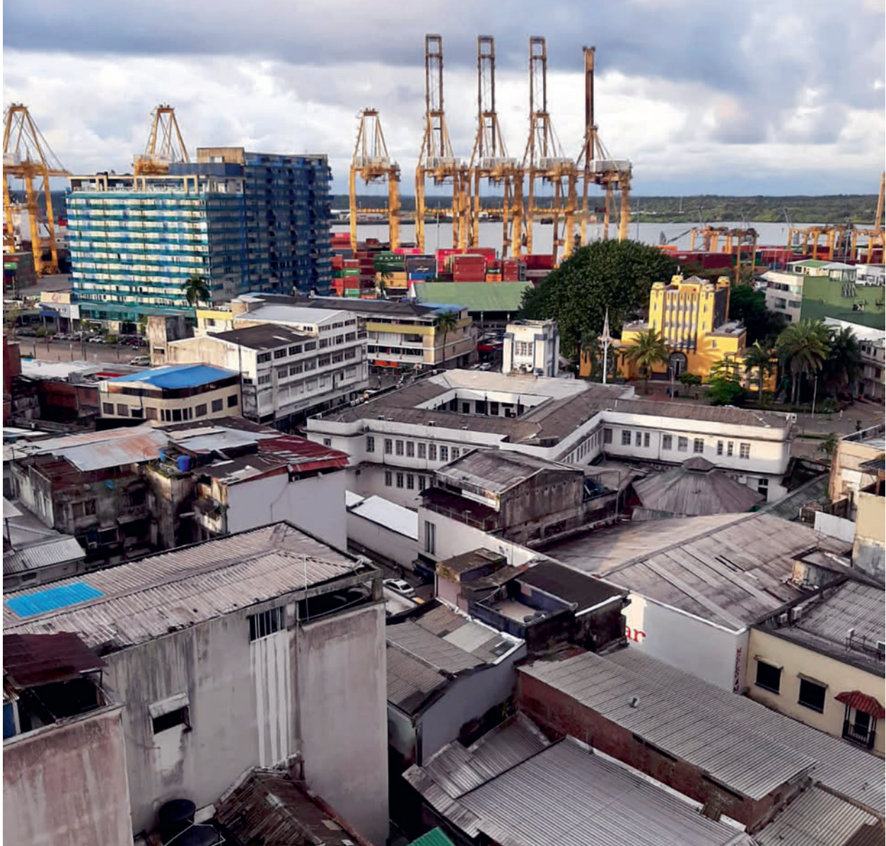
1 Die Stadt Buenaventura, Blick Richtung Hafen
