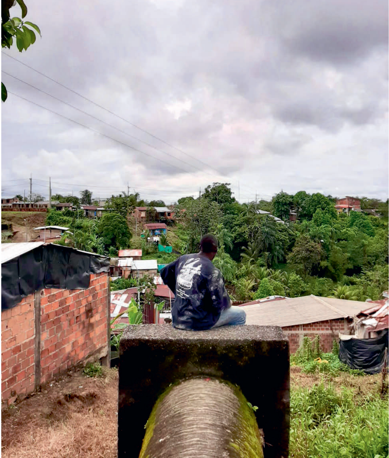
3 Wasserleitung in Ciudad Blanca
